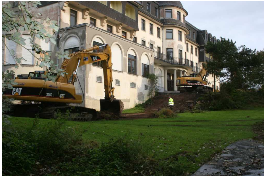
Startschuss für die Renovierung des Sanatoriums im Oktober 2011
