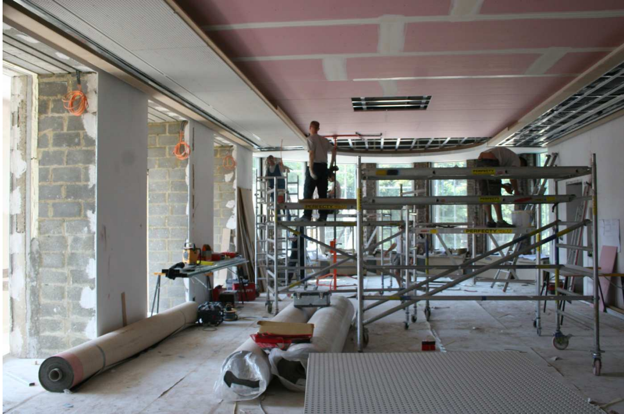
Blick auf die Baustelle
