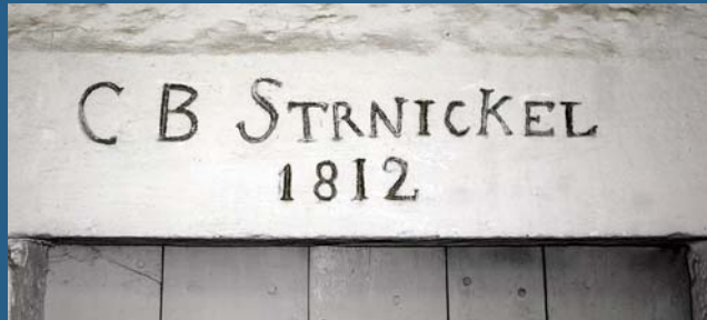
Türsturz im Gebäudekeller
