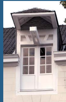
Oberhalb der Rückfassade befindet sich eine Lastzugvorrichtung unter einem kleinen Walmdach.
